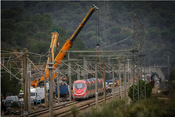
Labores de retirada del tren Iryo, en el apeadero de Adamuz donde se produjo el accidente. SERGIO ENRÍQUEZ NISTAL.
